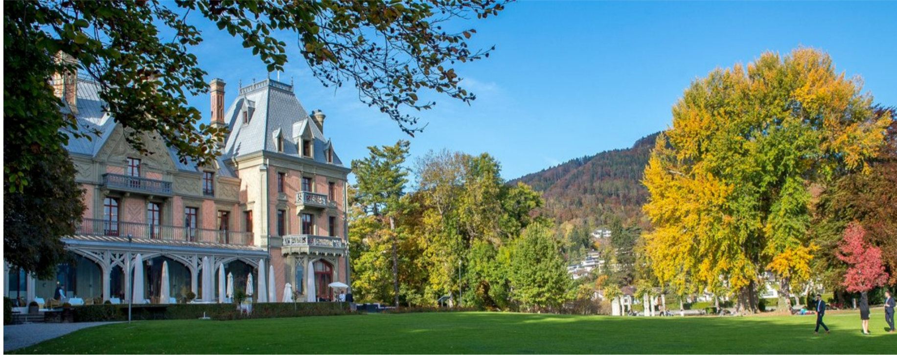
Das Schloss Schadau und der Park im Herbstkleid. Der Gastronomiebetrieb ist mittlerweile geschlossen, 2018 beginnen die Sanierungs- und Restaurierungsarbeiten.
